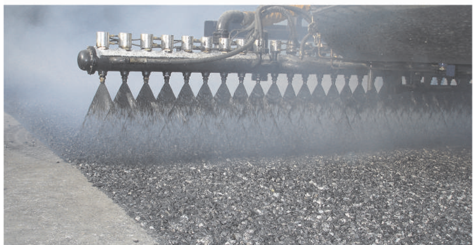
Figura 2. Espargimento da 2ª camada de Asfalto-borracha a 185°C.
