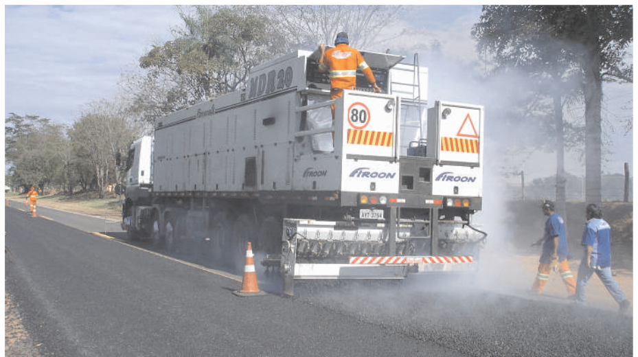
Figura 1. Detalhe da aplicação do ECOFLEX TS.
