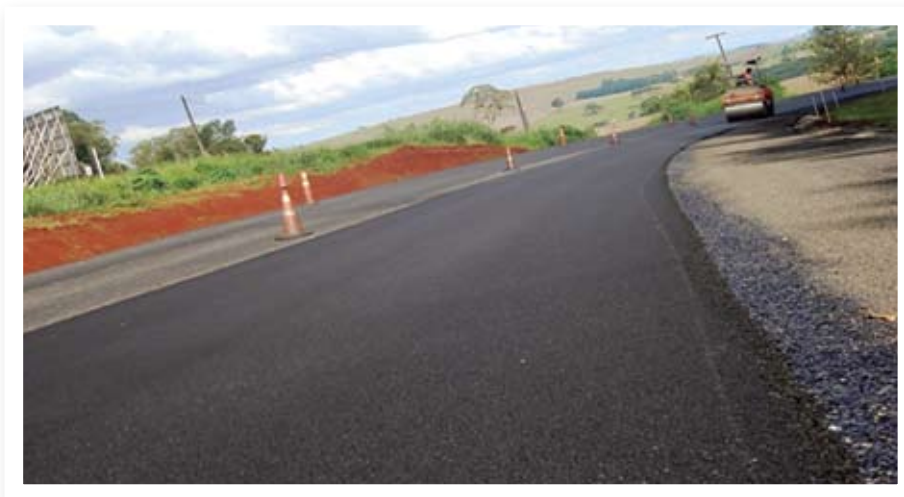
Figura 4. Aparência final da camada de rolamento.
