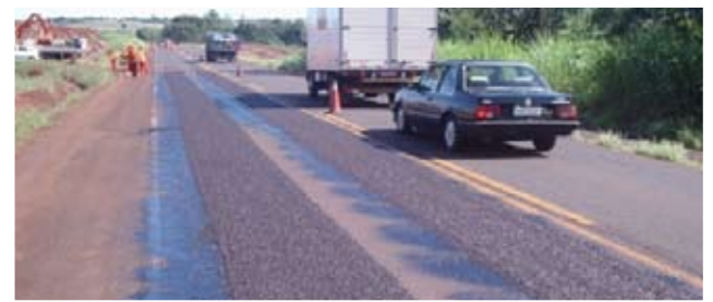
Figura 5 - Antes: pintura de Ligação com RR-1C-EP. Depois: trilhas de rodas preenchidas pelo MRAF.
