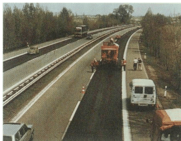
Figura 1. Preenchimento de trilhas de roda e posterior recobrimento, ambos com MRAF Alemanha, final da década de 60.
