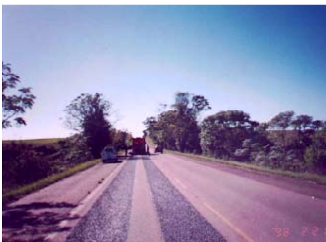
Figura 2. Esquema de preenchimento de trilhas com MRAF - BR 290/RS
