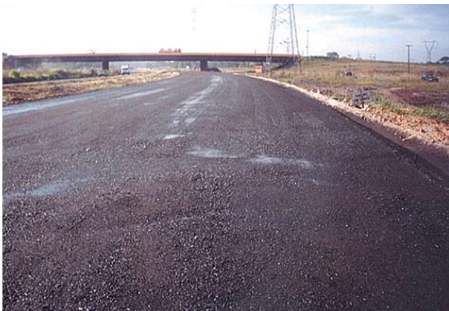
Aplicação da emulsão CM IMPRIMAÇÃO no contorno Sul (2003).
