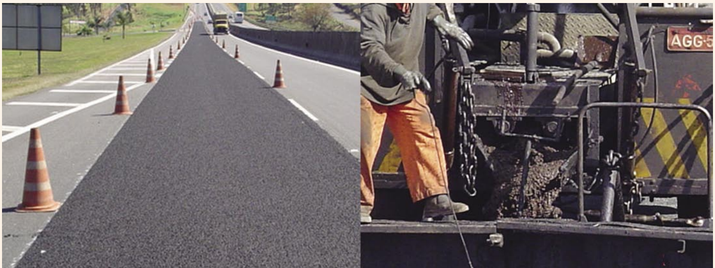
Micro revestimento Aplicado
