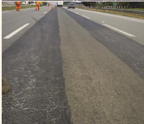
Trecho antes dos reparos
