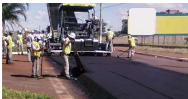
Fotos acima - Aplicação da camada para a regularização da rua com AMB
