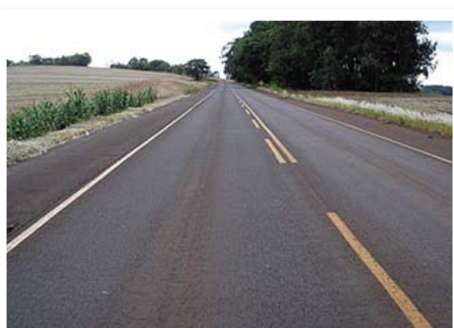
Figura 8 - Condições gerais de trechos da rodovia recuperada – 1 ano após a aplicação.
