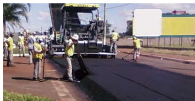
Fotos acima - Aplicação da camada para a regularização da rua com AMB
