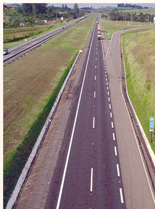
Aparência do trecho executado em Tatuí
